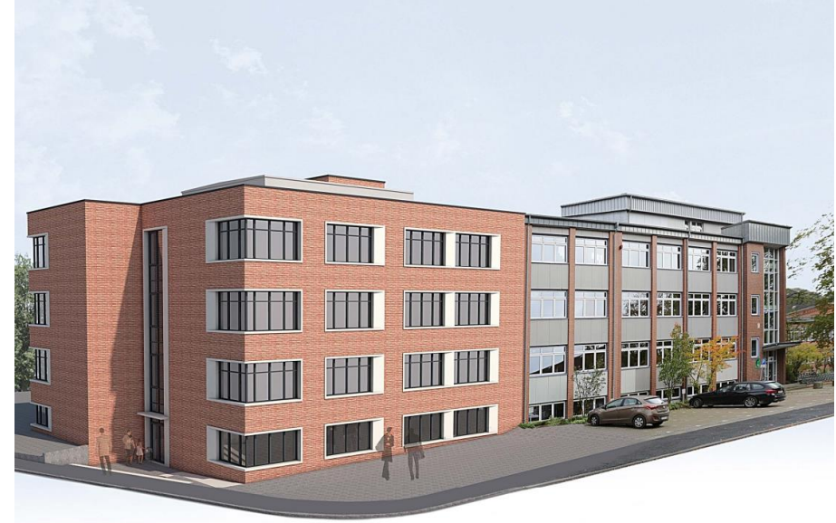
Aktuell im Bau befindlicher Anbau an das C-Gebäude (Foto: Stadt Wunstorf)
